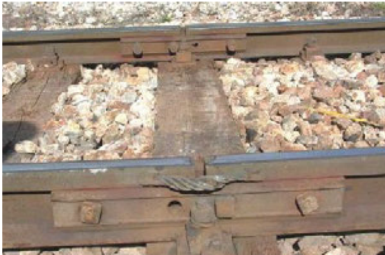
Şekil 2.1. Rayların cebire (fishplate) yardımıyla birleştirilmesi
