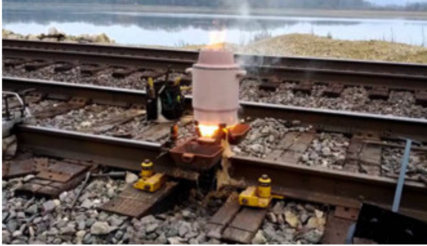
Şekil 2.2. Alüminotermite kaynağının uygulanması
